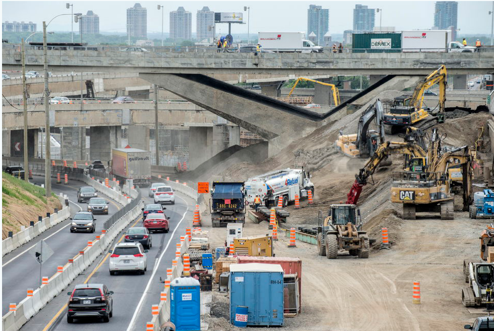
Fermeture de voies lors de travaux sur l'échangeur Turcot (Poirier, 2016)
