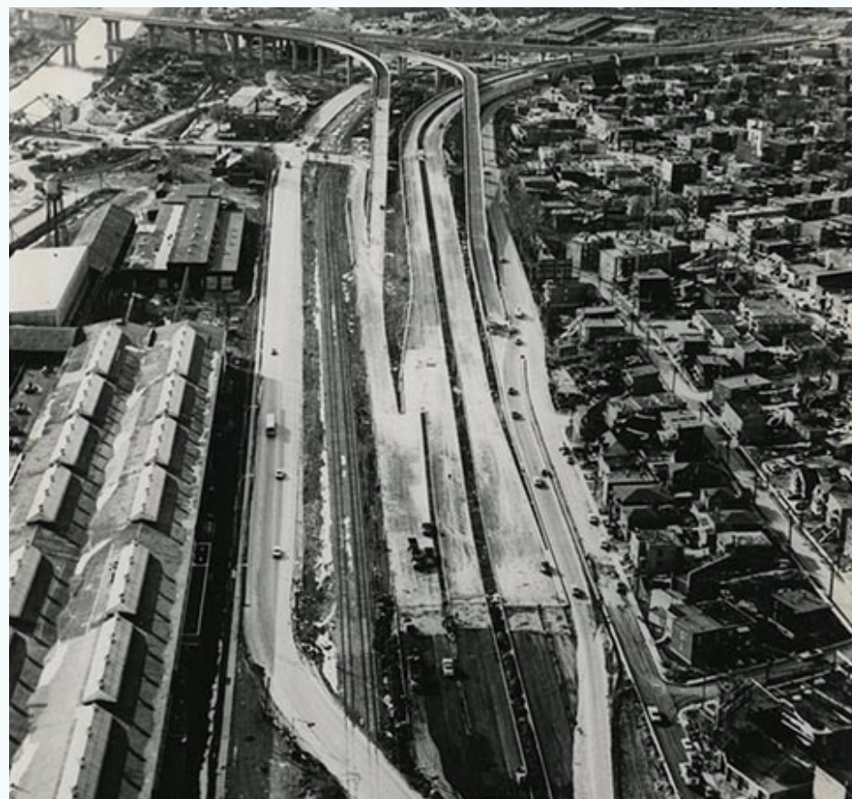
Construction de l'échangeur Saint-Pierre (circa 1965) (Transport, Mobilité durable et Électrification des transports, 2017)
